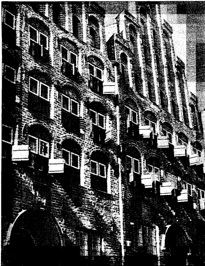
Die Brauhäuser Wahnstraße 54 und 56 nach ihrer Sanierung im Jahr 1986.
